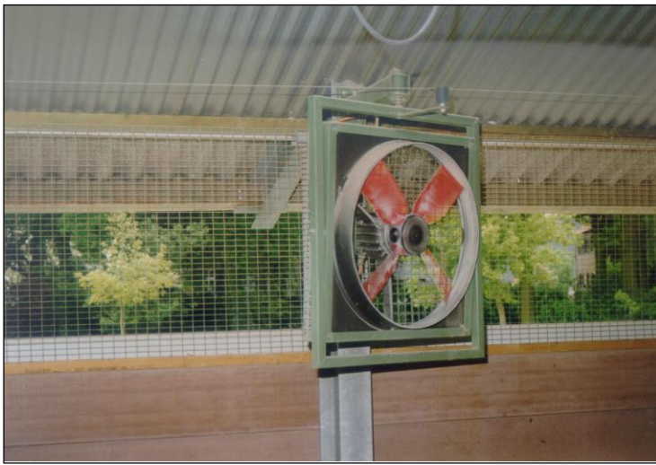
Abbildung 5: Schwenkventilator zur Unterstützung der Luftbewegungen
