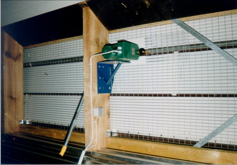
Abbildung 4: Stellmotor zur Regulierung der Sandwichpaneele bzw. Doppelstegplatte
