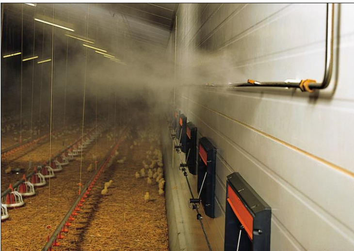
Abbildung 9: Hochdruckverdunstungskühlung über den Zuluftklappen
