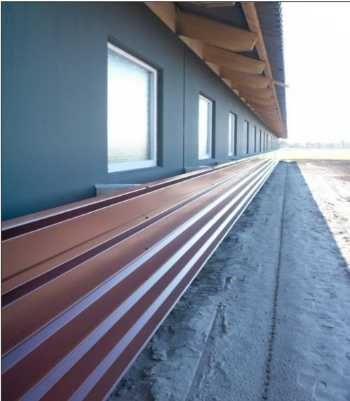
Abbildung 8: Abdeckung der Zuluftventile durch eine waagrecht angebrachte Wellblechplatte
