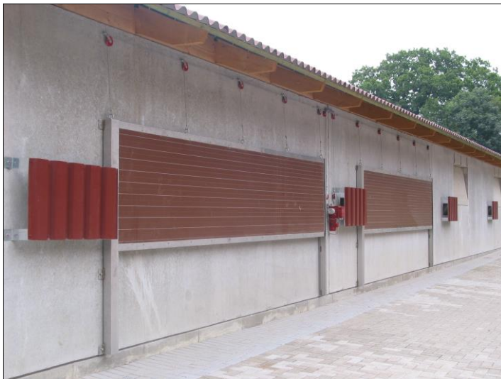
Abbildung 7: Zuluftöffnungen einer Tunnel- bzw. Mehrphasenlüftung
