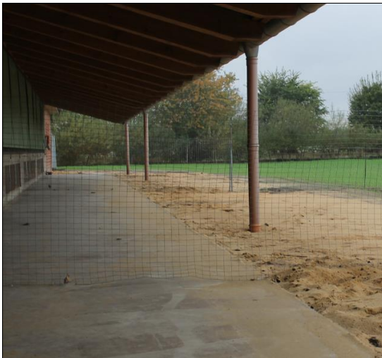
Abbildung 94: Übergangsbereich mit Dachüberstand – Untergrundmaterial ist Sand oder Betonsockel. Ein Bodenaustausch oder Anсандen ist aus hygienischen Gründen wichtig!
