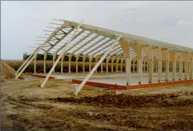
Abbildung 6: Holzrahmenbauweise eines Putenstalles mit ‚Freier Lüftung‘
