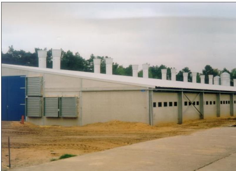
Abbildung 10: Geteilte Abluft; verteilte Abluftventilatoren über dem First sowie zusätzliche Giebelventilatoren
