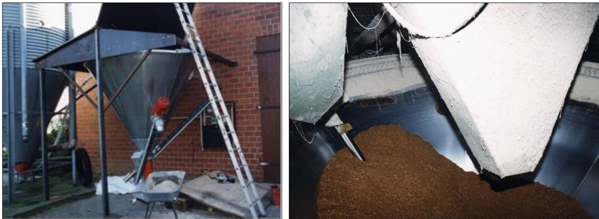
Abbildung 52: Mischanlage für die Weizen-Beifütterung
